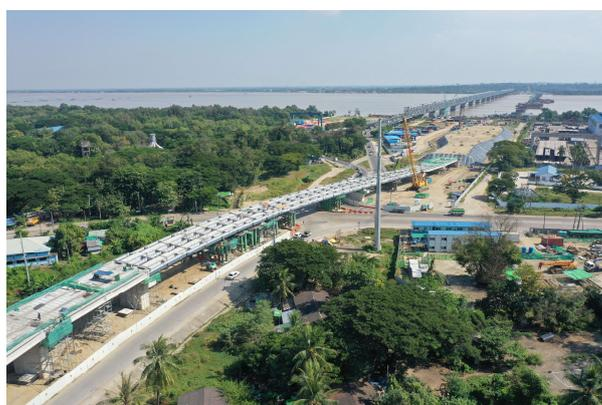
写真-5 鋼桁架設直後
