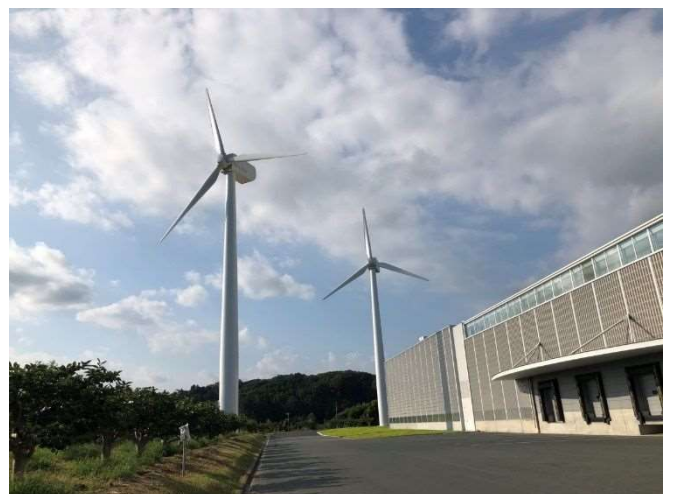
写真-5 工事完了
