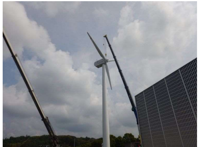
写真-4 ローター架設状況
