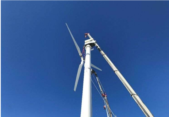
写真-2 既存風車の撤去状況
