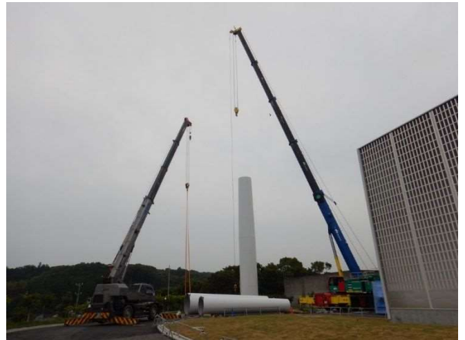
写真-3 タワーの建設状況（2号機）
