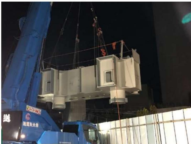
100t吊トラッククレーンによる梁架設
