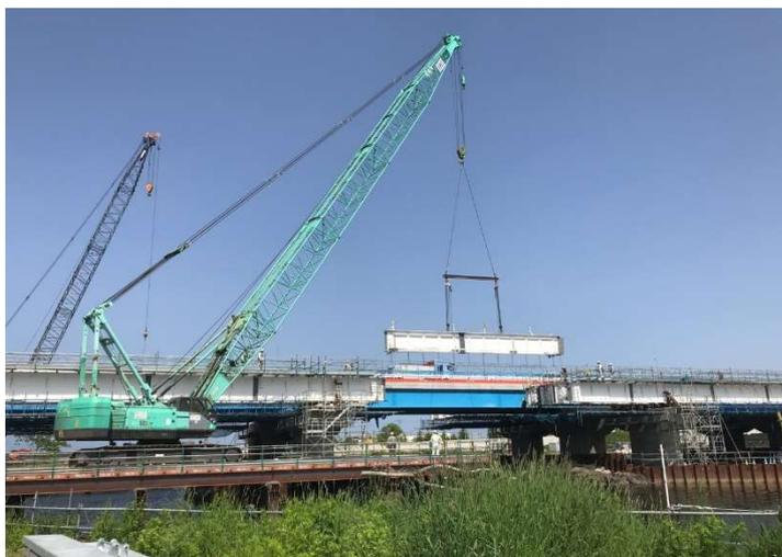
100t吊クローラクレーンによる主桁架設
