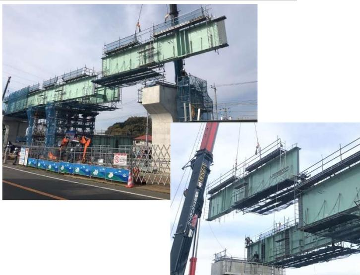
120t 吊トラッククレーンによる主桁架設
