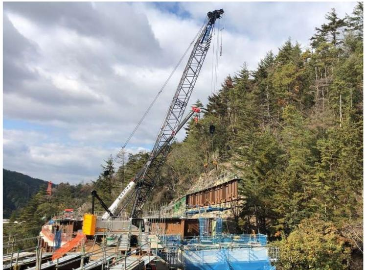
構台から100t吊クローラクレーンによる架設
