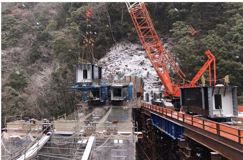
構台から 150t 吊クレーンによる架設
