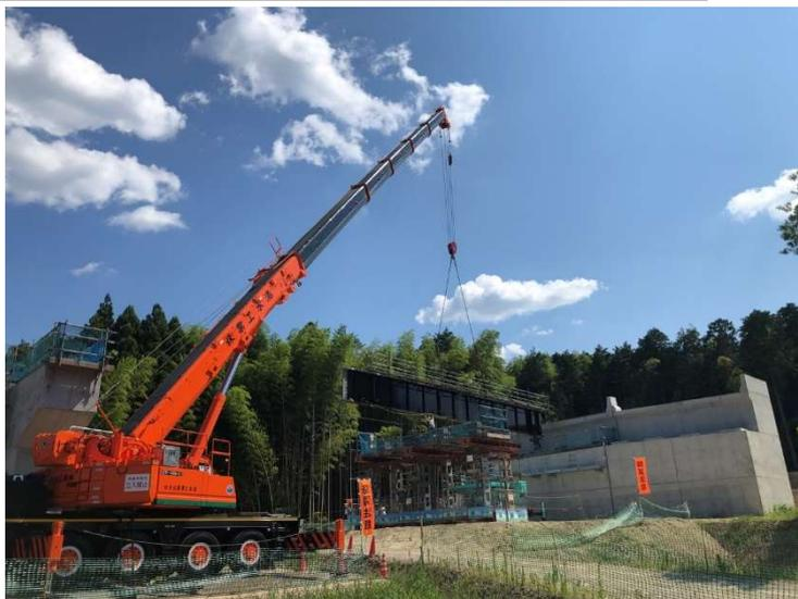
120t吊オールテレーンクレーンによる架設
