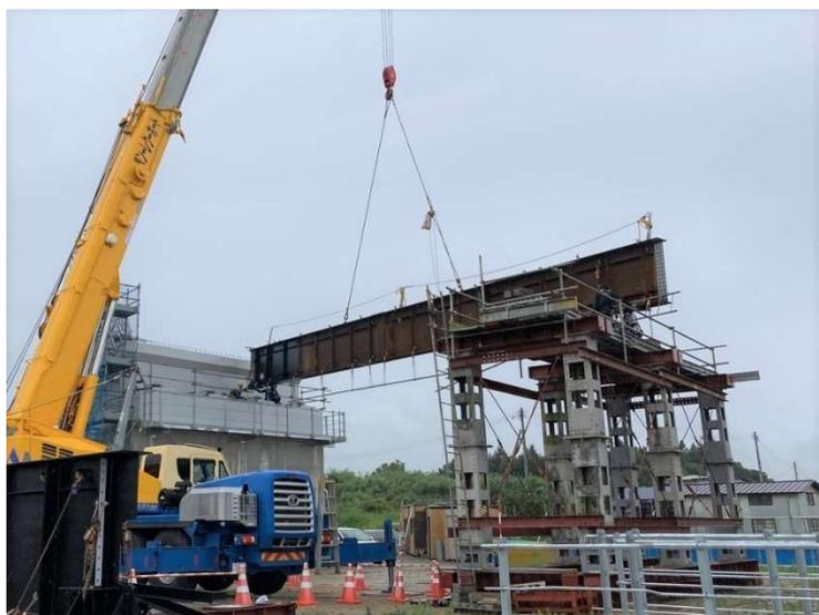
80t吊オールテレーンクレーンによる主桁架設
