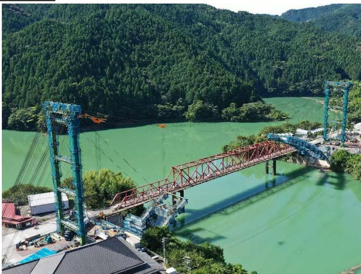
ケーブルエレクション斜吊工法によるアーチリブの架設
