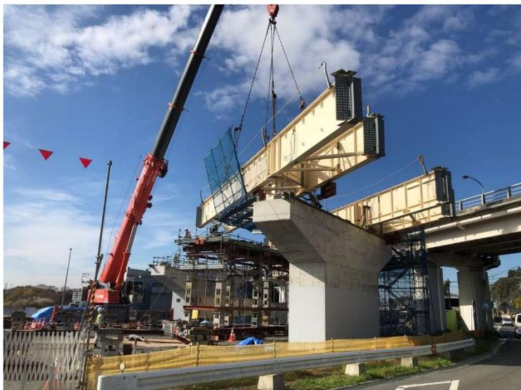
100t 吊トラッククレーンによる主桁架設
