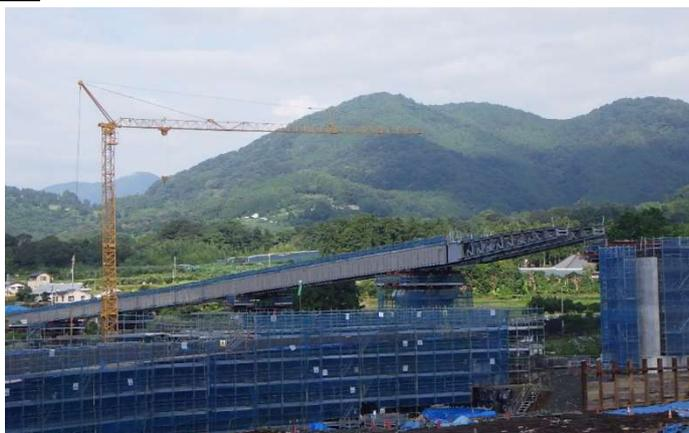
手延べ機を用いた送出し架設（秦野 SA A ランプ橋）
