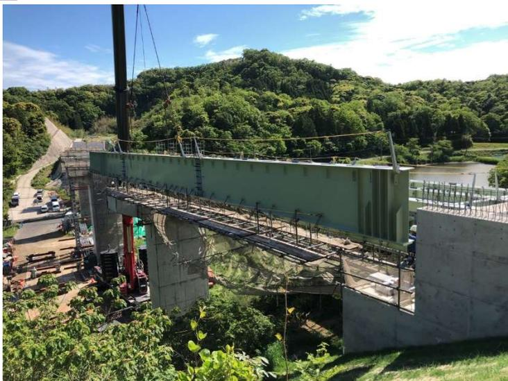
400t 吊オールテレーンクレーンによる架設
