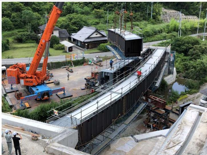
150t 吊クローラクレーンによる架設
