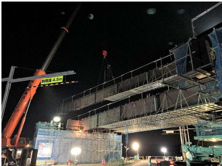
120t 吊クローラクレーンによる架設
