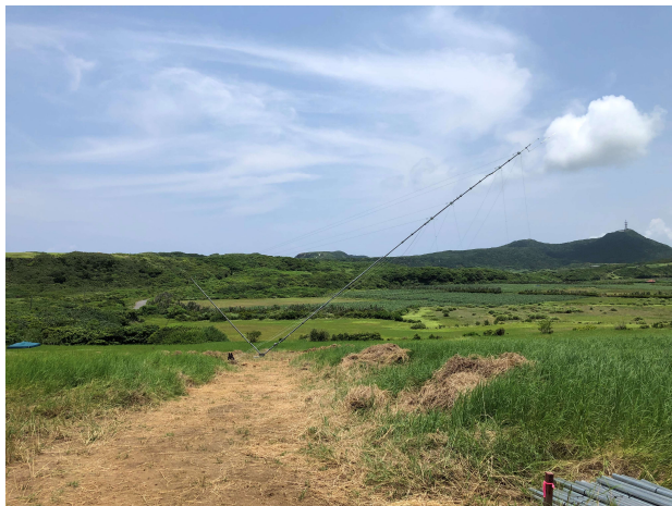
マスト施工状況
