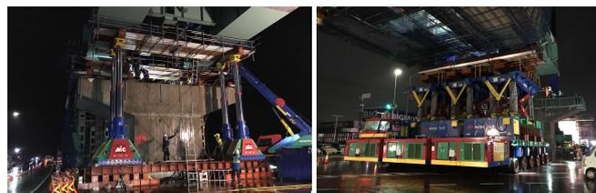
写真-3 桁降下設備
