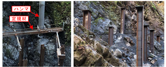
写真-1 杭施工状況
