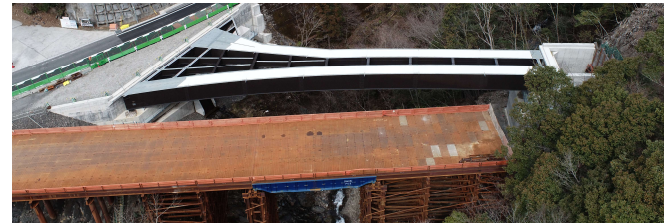
写真-3 架設完了
