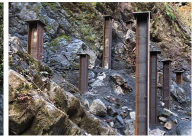
写真-2 杭施工完了
