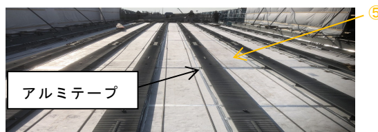
写真-4 埋込型枠組立完了
