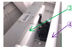
写真-3 型枠組立状況
