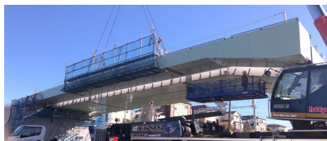
写真-2 B橋 交差点上架設状況
