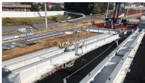
写真-1 B橋 地組ヤード
