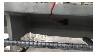
写真-5 センサー取付状況
