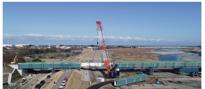
写真-9 落とし込み架設状況
