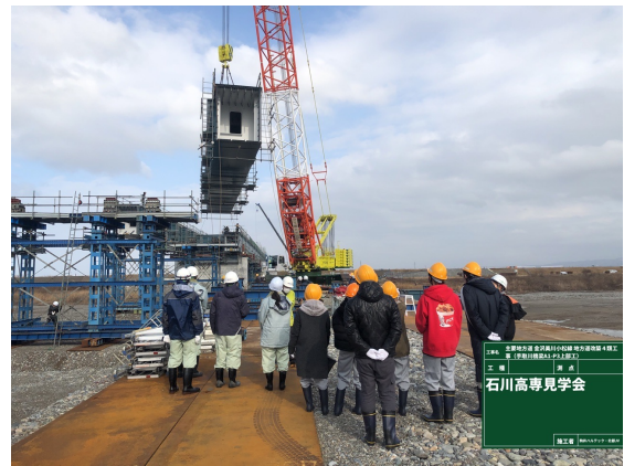
a) 架設状況の見学
