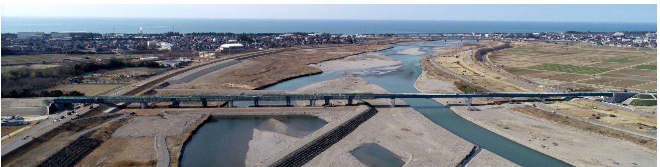
写真-11 架設完了状況
