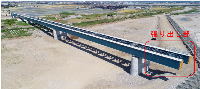
写真-3 1期施工完了時
