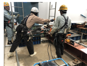
写真-2 縦送り状況
