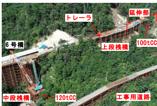
写真-1 栈橋等とクレーンの配置状況
