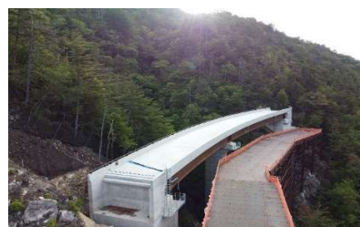
写真-6 完成写真
