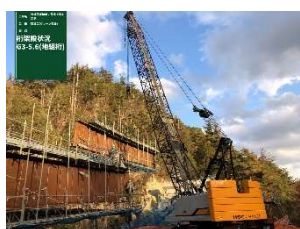
写真-3 架設状況
