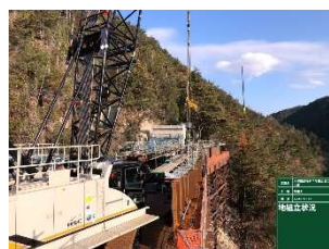
写真-2 地組立て状況
