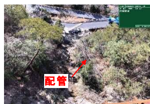
写真-4 配管圧送状況
