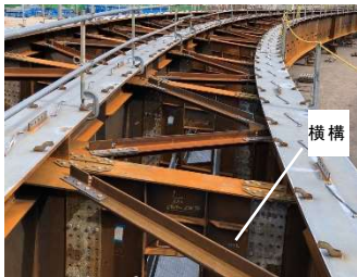
写真-1 横構（十字断面）
