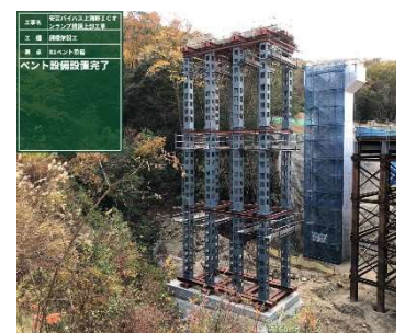
写真-4 ベント設置完了
