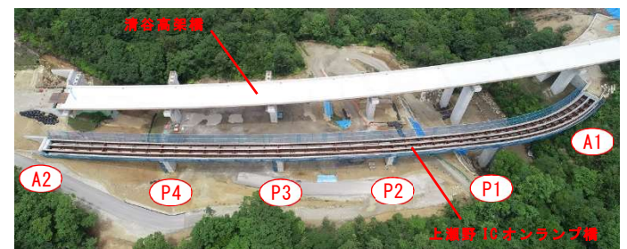
写真-5 施工完了
