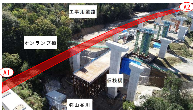
写真-2 仮栈橋設置状況
