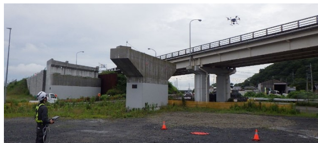
写真-2 UAV 測量
