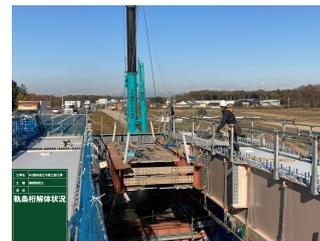
写真-3 軌条設備解体状況
