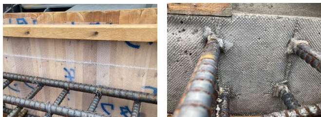
写真-1, 2 KK シート貼り付け完了・剥離後
