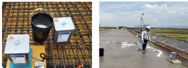
写真-3, 4 キュアキーパー計測状況・散布状況
