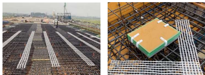
写真-5, 6 ハイパーネット設置状況
