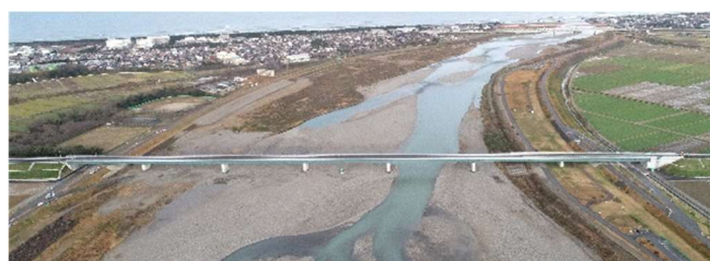
写真-7 完成した手取川橋梁(ドローン撮影による)
