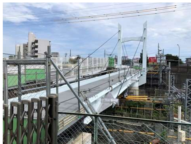
写真-1 張力調整完了状況
