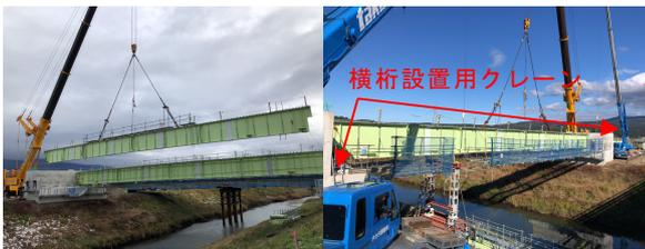
a) 主桁架設状況      b) 横桁架設状況
