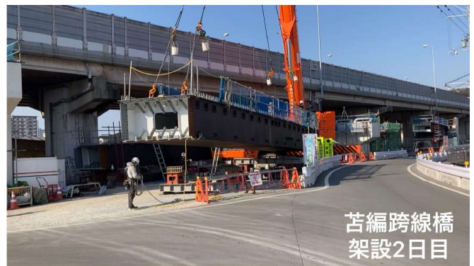
写真-1 桁架設状況写真（P5-A2）
