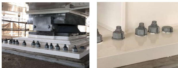
写真-6 アンカーボルト頭部の閉じボルト設置状況
