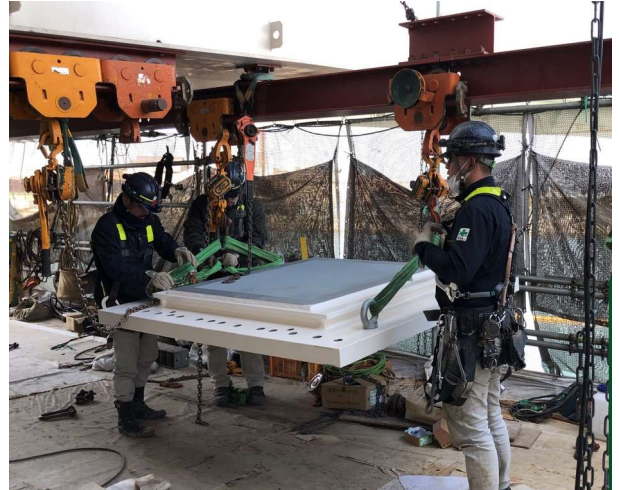
写真-2 鋼製台座の部材運搬状況
