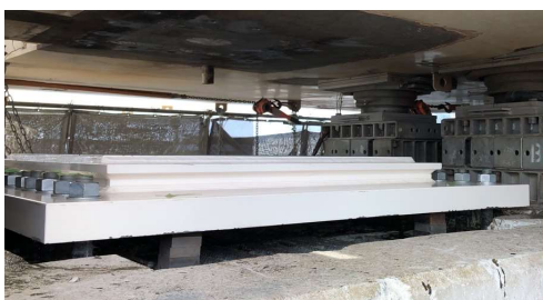
写真-5 アンカーボルト引上げ設置完了
