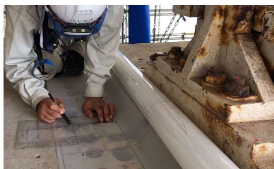
写真-8 アンカー削孔位置計測状況
